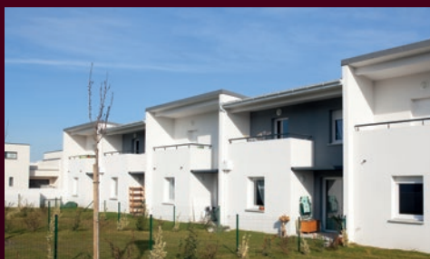
IDRON - LES ALLÉES DE SULLY 14 logements
